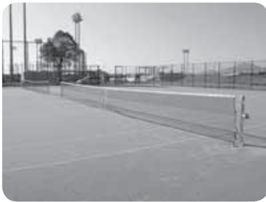
完成した総合運動公園テニスコート
