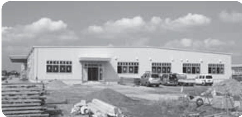
来年1月の全面開業を目指して建設中のハタノ本社・工場
