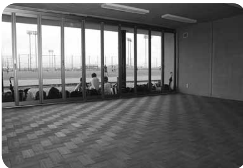
多目的競技場から直接出入りできる多目的室
