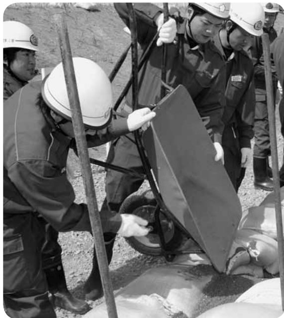
土のう積み工法に取り組む嘉島町水防団員
