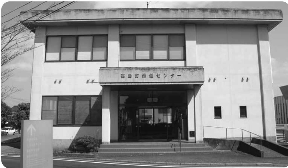
子育て支援の活動拠点として 整備される旧保健センター
