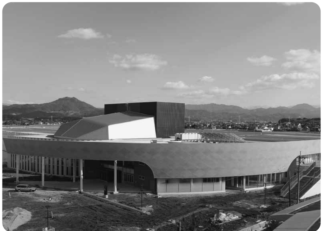
3月16日オープン予定の嘉島町民会館
