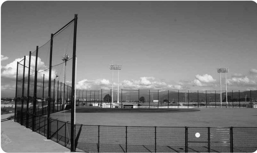
平成24年8月に完成した野球場
