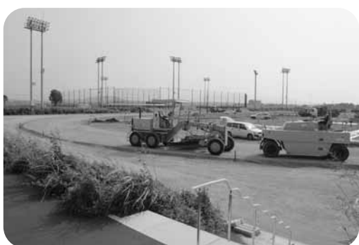
多目的競技場の整備工事
