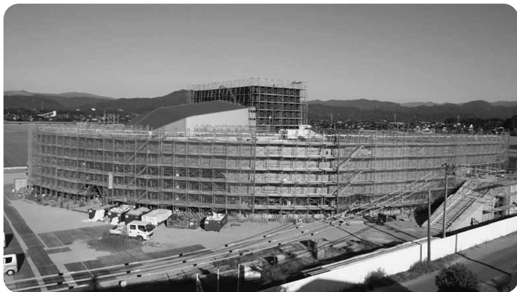
順調に工事が進む嘉島町民会館
