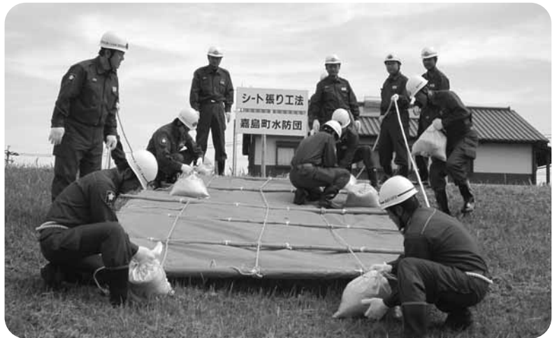
嘉島町水防団によるシート張り工法
