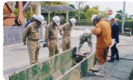
下水道工事(上島地内)
