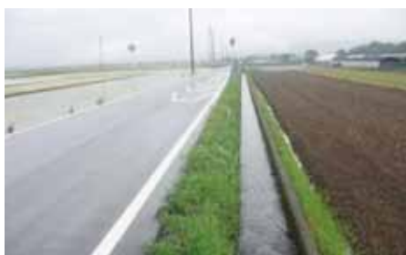
町道浮島線南側水路
