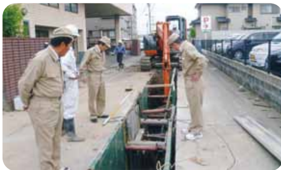
下水道工事(鯉地内)
