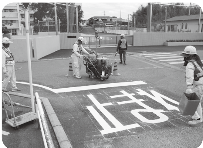
町建設業協会が行った道路標示の塗り替え作業
