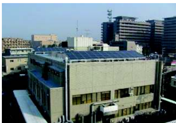
太陽光発電（上下水道局別館）
