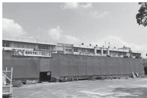
建設中の嘉島東小学校
