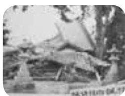
平成3年の台風被害を伝える写真
