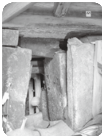
鉄骨や木材で補強された石室の入り口
