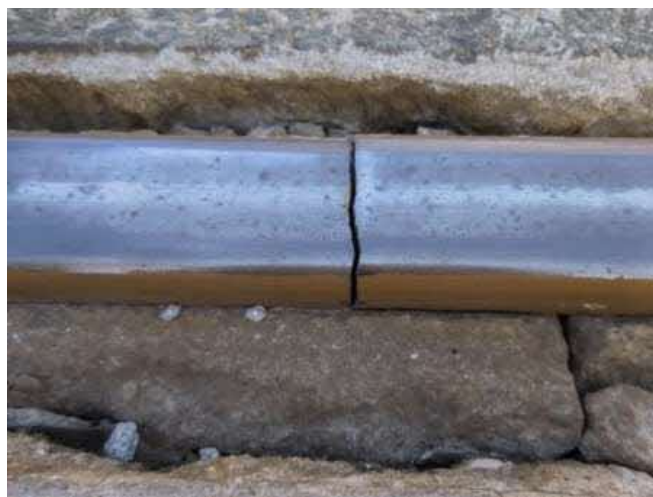
市電レールの破断
