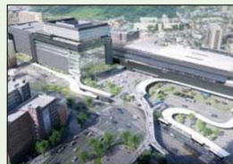
熊本駅白川口（東口）駅前広場
