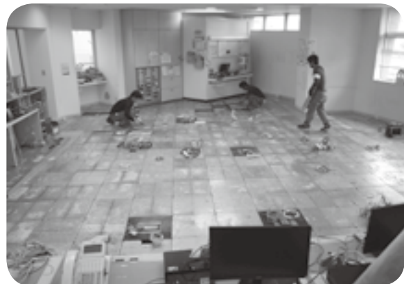
床マットをはがし、床内部の点検が行われる町民保険課
