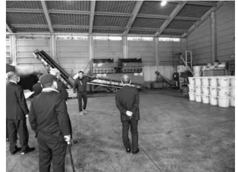
生ごみ堆肥化施設
