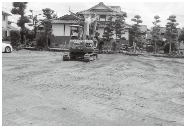
造成中のグラウンド・ゴルフ場
