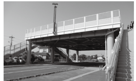
津波避難タワー 有効面積628m 2 ・収容人員1,200人
