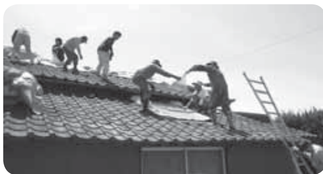
↑ 雨漏り防止の共同作業（上六嘉区、4月20日）
