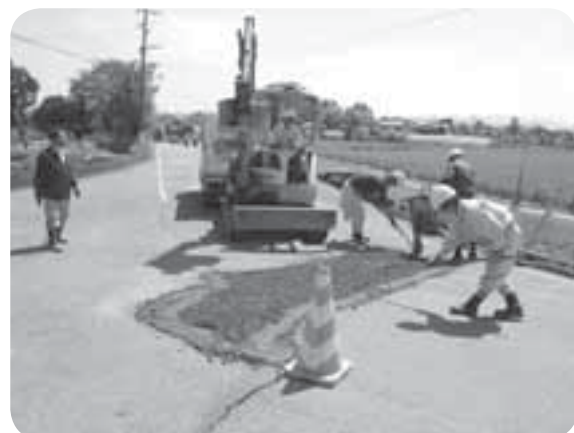
◀道路破損個所の応急工事 (上六嘉、4月20日)
