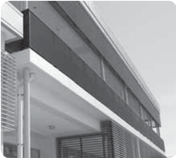
完成した嘉島西小の新校舎
